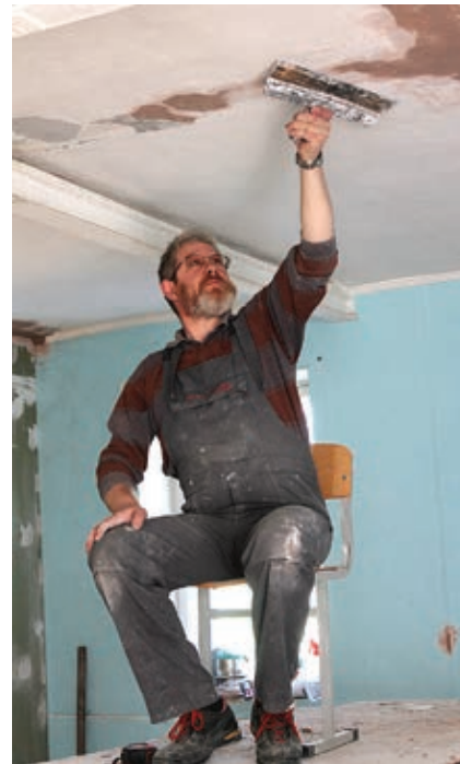
Строительно-ремонтные работы в самом разгаре
